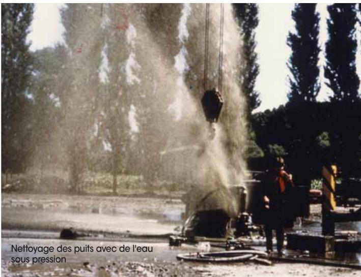
Nettoyage des puits avec de l'eau sous pression
